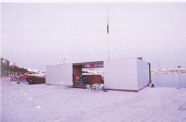
Terminal en Alicante, 1997-2000.
